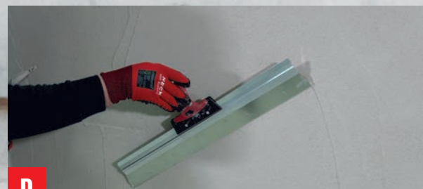
D Eine zweite Lage HECK K+A SL in 2 mm Schichtstärke aufbringen, Oberfläche glätten.
