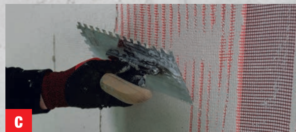
C Armierungsgewebe HECK AGG einbetten.
