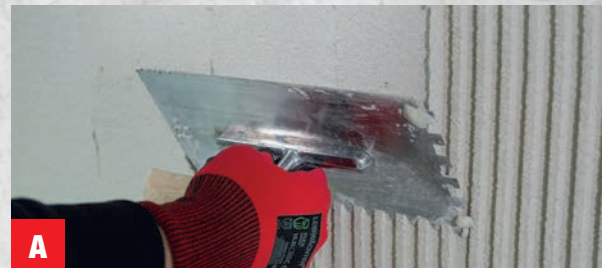
A HECK K+A SL mit der Zahntraufel aufbringen.
