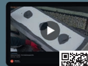
Dämmplatten kleben
