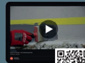
Dichtungsschlämme
